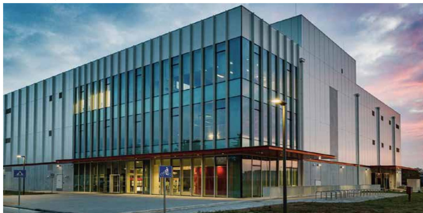
DATA CENTER EQUINIX - MILANO
